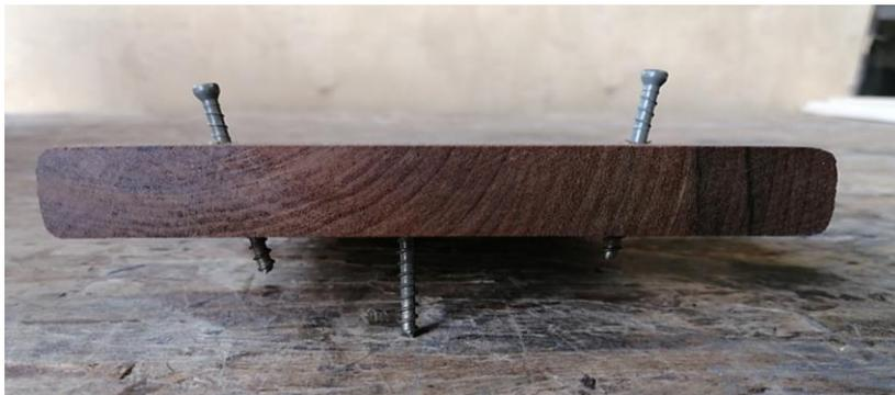
Con destornillador Insertar la punta T-15 con tornillo punta de broca dejando que ella siga abriendo su guía hasta el bastidor o underdeck.
